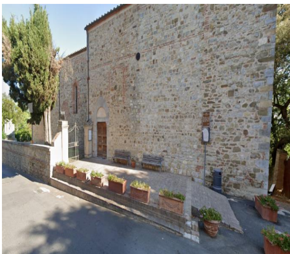
51 Rampa ingresso Chiesa santa Maria13
