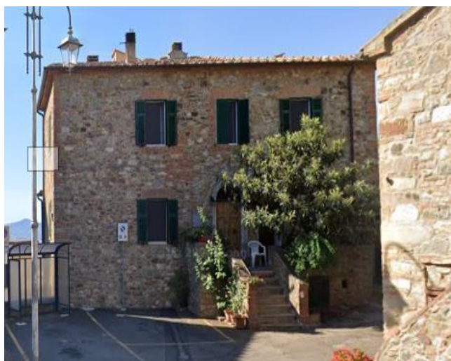
3 Strada Provinciale Campagnatico, dopo Vicolo di Bellaria
