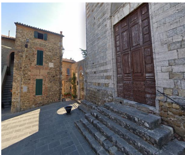
166 Portale di ingresso con gradini
